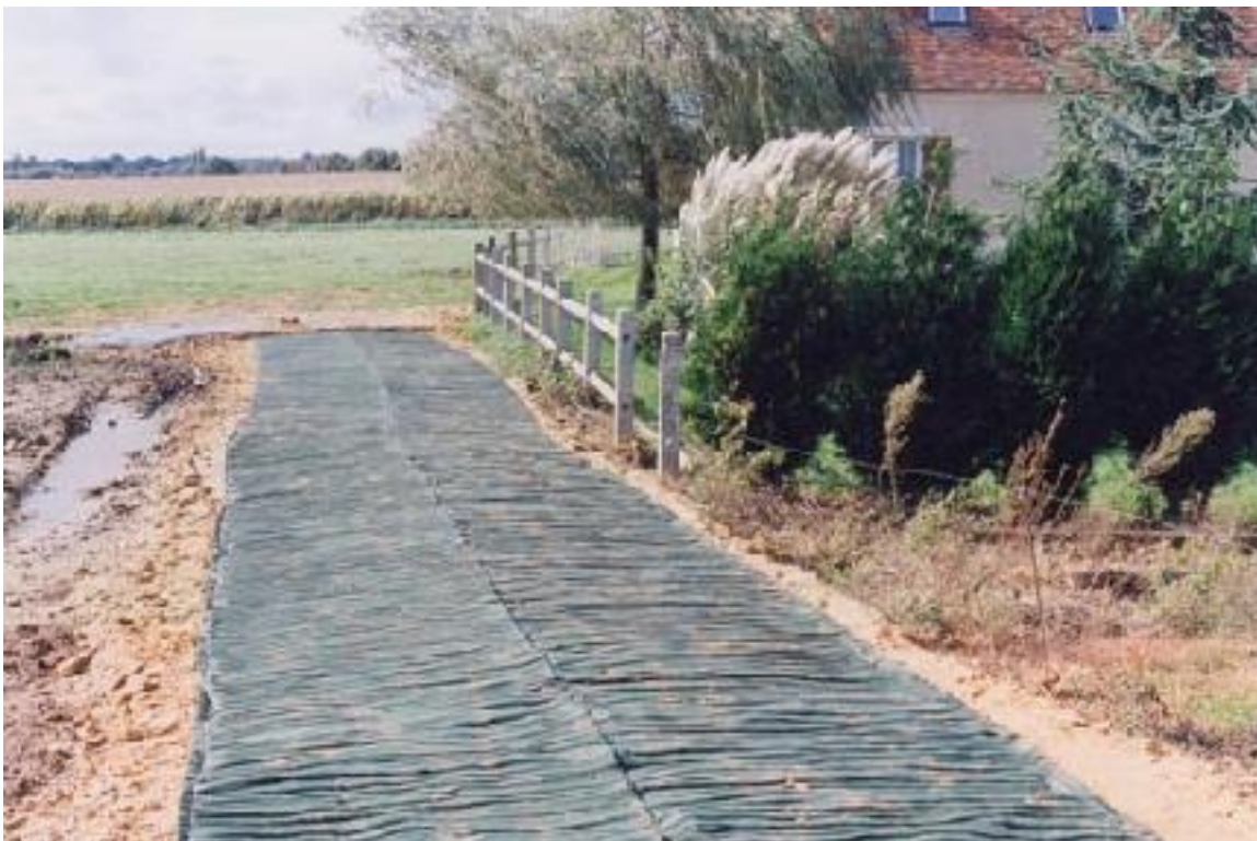
Maintenant, grâce à TexWay® , le chemin est stable et propre
