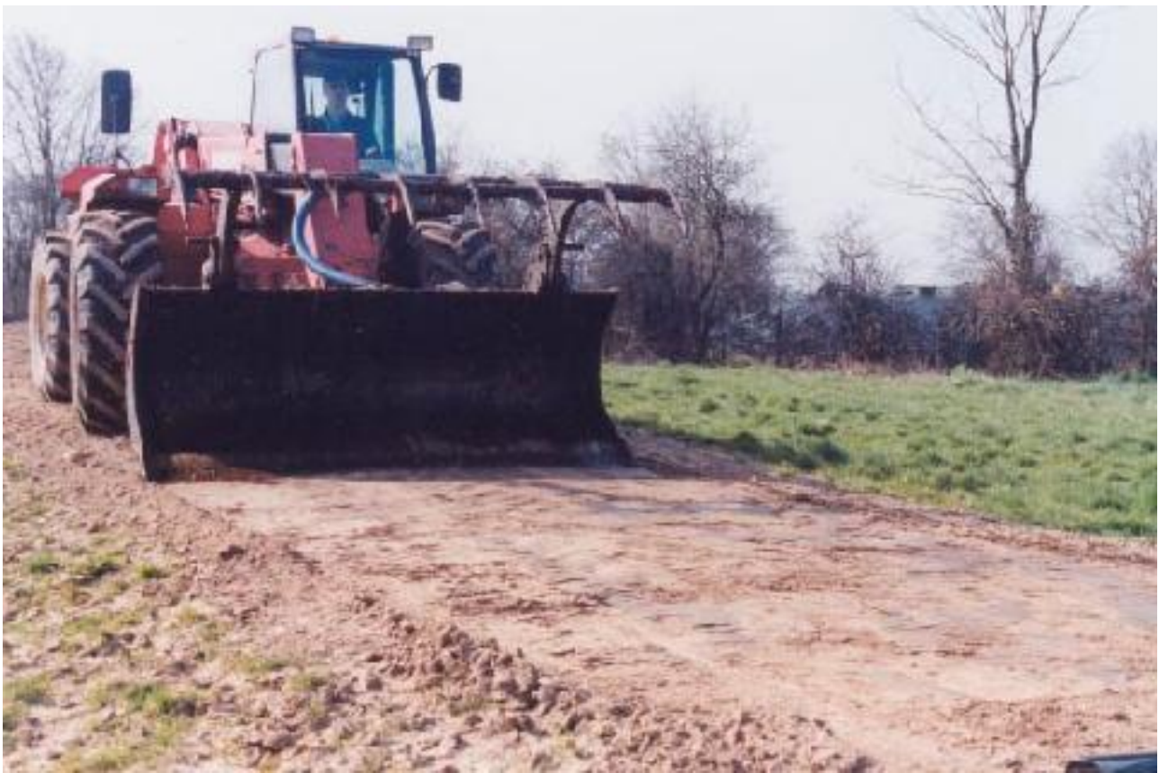
Lisser le sol avec une lame. Enlever les pierres en surface.
