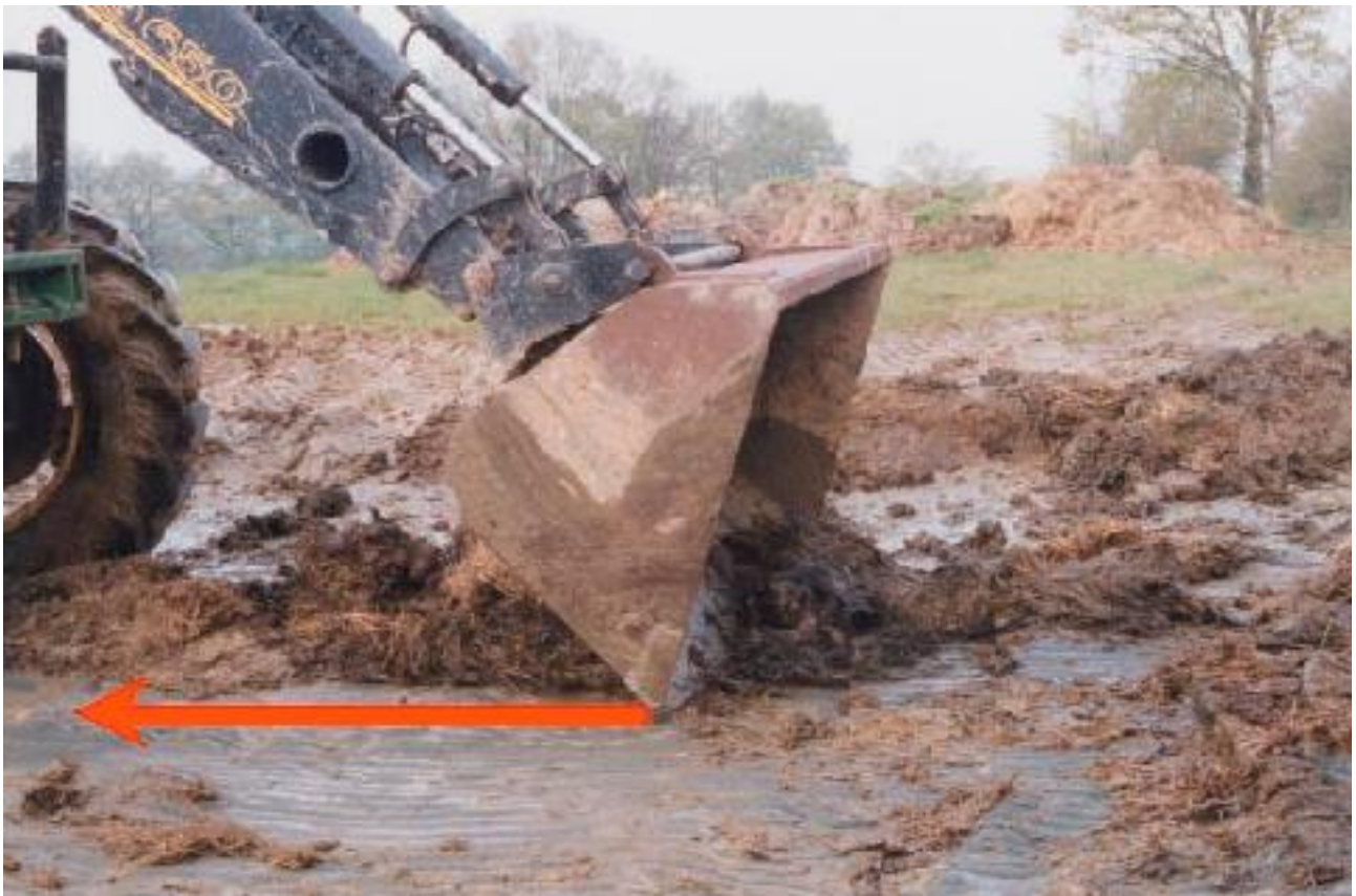
Il est possible de nettoyer le TexWay avec une lame. Racler doucement en marche arrière pour éviter d'abîmer le produit.
