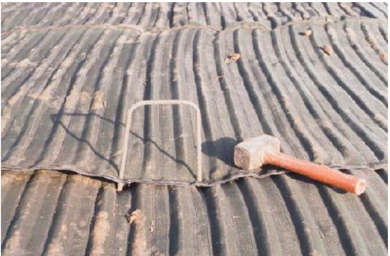
Superposer les différentes pièces de TexWay aux jonctions. Fixer le TexWay avec des broches métalliques.
